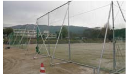
完成した中学生が使用する仮設グラウンドのフェンス
